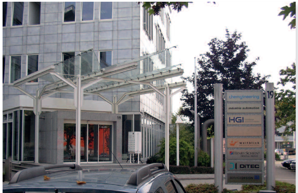
Die weitblick-Büroräume in Rohrbach-Süd
